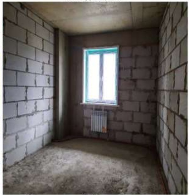
10. помещение № 5 - жилая комната
