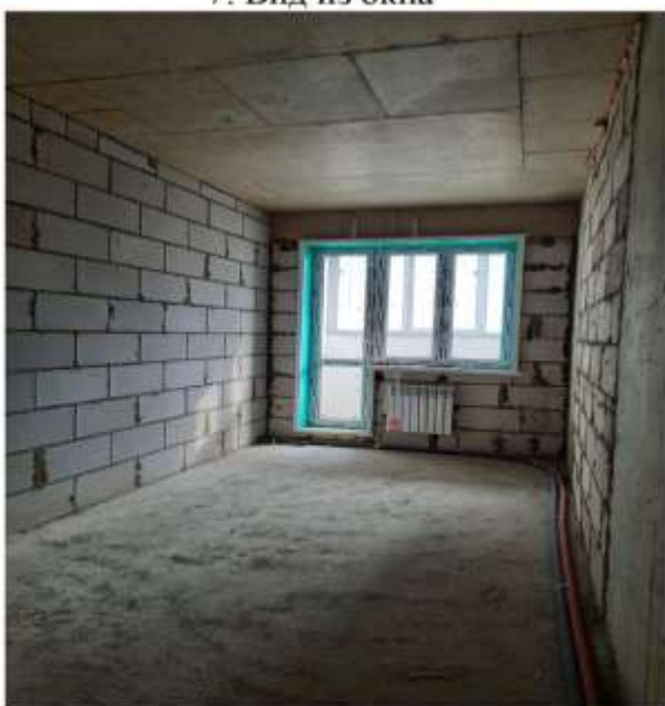
9. помещение № 4 - жилая комната
