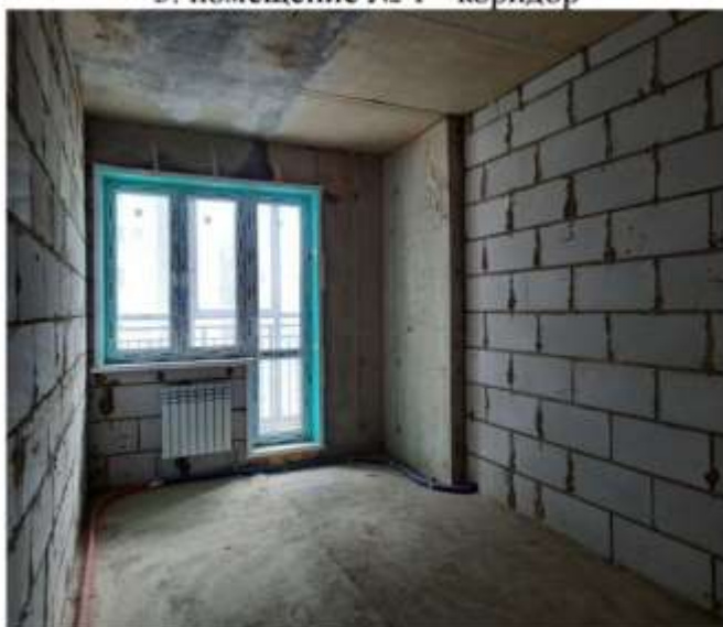
5. помещение № 3 - жилая комната
