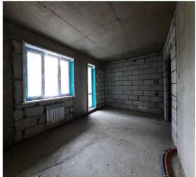
14. помещение № 7 - жилая комната
