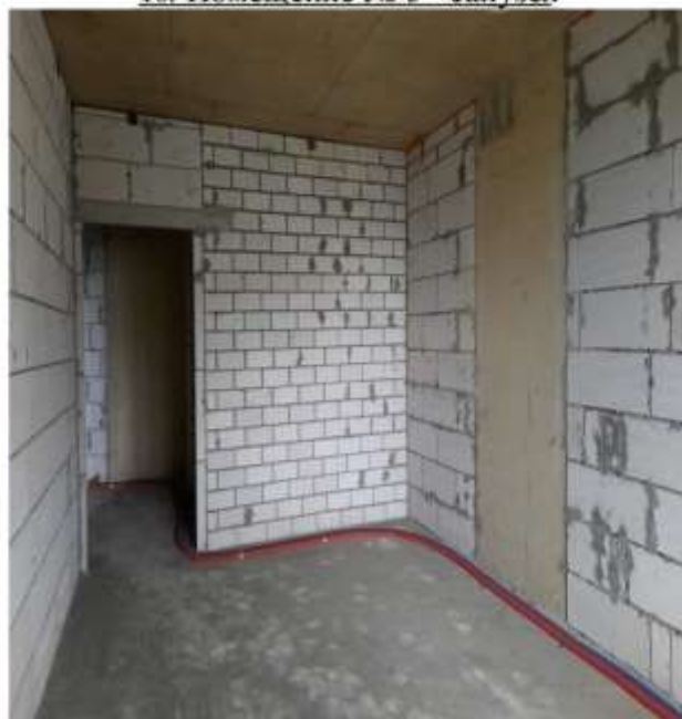
12. Помещение № 6 - жилая комната
