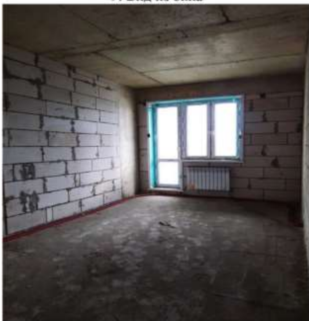
11. Помещение № 6 - жилая комната
