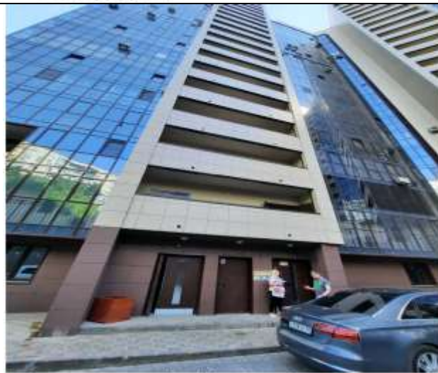
Фасад здания (1-ый подъезд)
