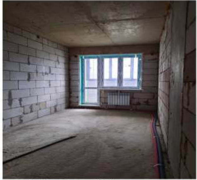
8. Помещение № 4 - жилая комната
