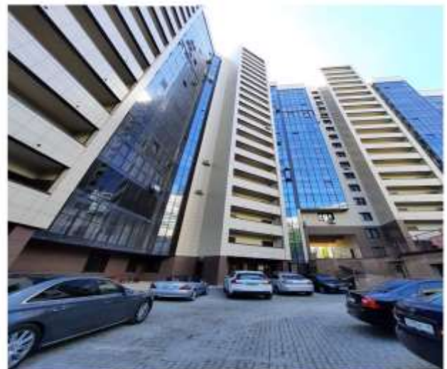
Фасад здания (2-ой подъезд)
