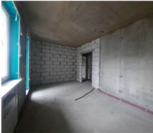
13. Помещение № 7 - жилая комната
