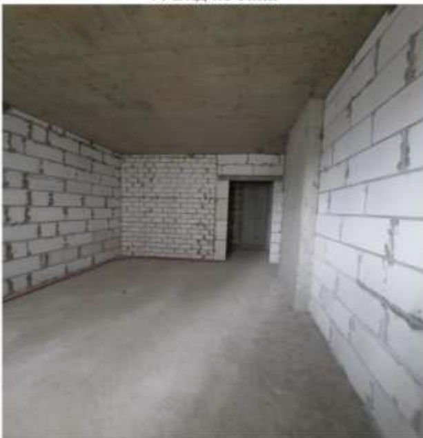
11. помещение № 5 - жилая комната
