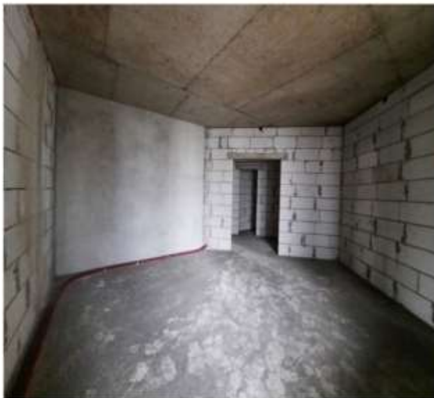
7. Помещение № 4 - жилая комната
